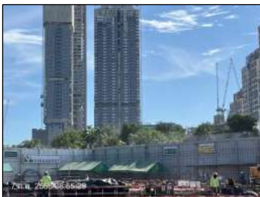
ภาพที่ 2 รั้ว Metal Sheet สูง 6 เมตร
