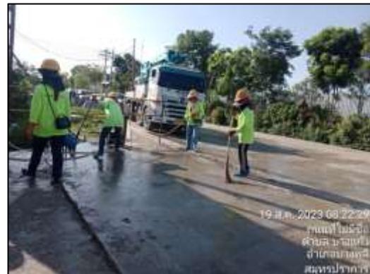
ภาพที่ 10 คนงานฉีดพรมน้ำและกวาดทำความสะอาดบริเวณพื้นที่ก่อสร้าง
