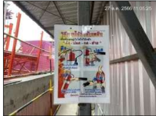
ภาพที่ 33 ถังดับเพลิง และป้ายแนะนำการใช้งาน
